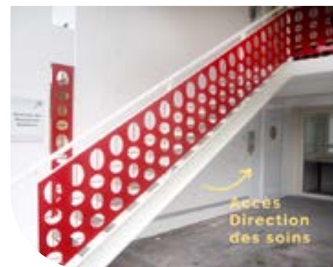
■ Rénovation de la Direction des Ressources humaines à Sèvres.
