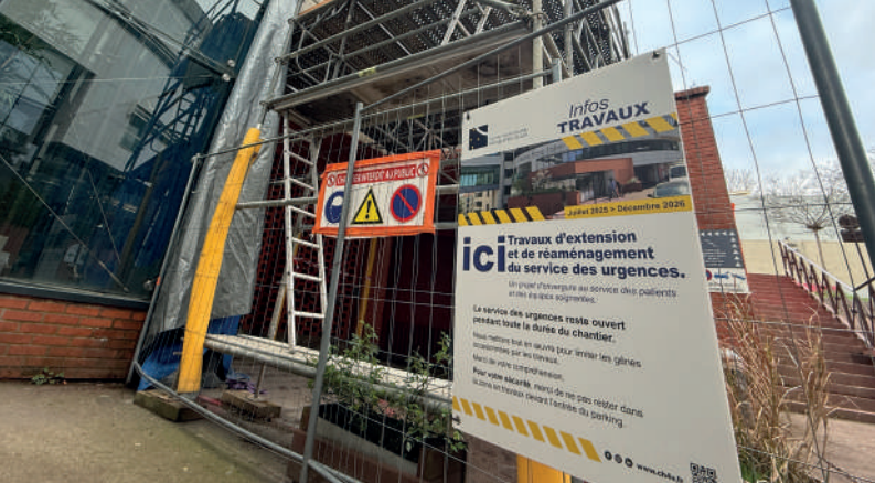
05. de chantier de l'extension du service des Urgences : travaux en cours (février 2026) © CH4V
